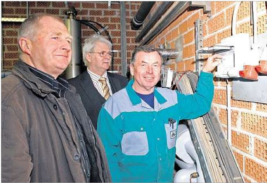
Symbolisch setzte gestern der Pahrenr Agrar-Mitarbeiter Roland Buklitsch im Beisein von Bürgermeister Frank Steinwachs (M.) und Albrecht Broßmann (L.), Geschäftsführer der Pahren Agrar, die Nahwärmeleitung in Gang. Durch die Biogasanlage werden Vereinshaus und Kindergarten in Pahren beheizt. (Foto: OTZ/Heidi Henze)
