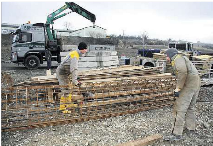
Unterhalb des Rinderstalles von Niederböhmersdorf haben die Arbeiten an der Biogasanlage der Ervema Agrar Wöhlsdorf begonnen. Marcel Helmer (links) und Tobias Wagner von der Firma Wolf System Osterhofen flechten die Bewehrung für die beiden Stahlbeton-Mittelstützen der zwei Gärbehälter. (Fotos [2]: OTZ/Steffen Beikirch)
