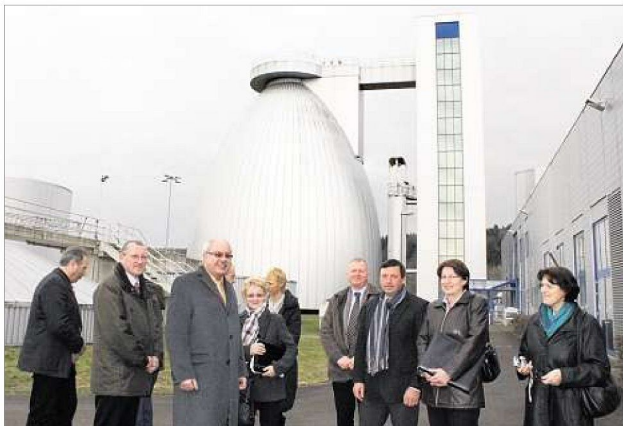
Der Faulturm ist das Herzstück des Kraftwerkes Klärwerk in Gera-Stublach. Nach der Erneuerung der Blockheizkraftwerke kann sich das Klärwerk nun mit Unterstützung der Bioenergieregion Thüringer Vogtland vollständig mit selbst produziertem Strom und Wärme versorgen. (Foto: OTZ/Angelika Munteanu)
